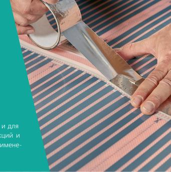
Алюминиевые ленты применяется как в быту, так и для улучшения изоляционных характеристик конструкций и оборудования на производствах. Температура применения этих лент от -40°C до +120°C.
